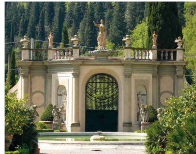
CALENZANO (PO) VILLA TRAVALLE
